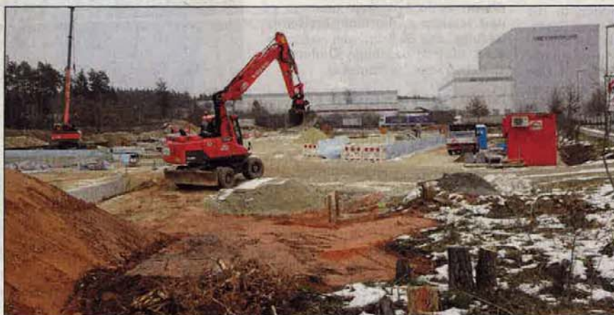
Vor der Stahlgruber-Kulisse werkeln die Baumaschinen: Im Juli soll hier der Umzug stattfinden. Bilder: Gebhardt (3)
