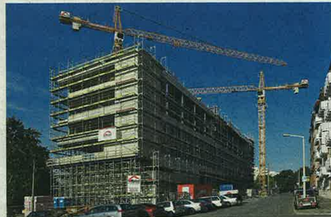
Rohbau „CNO“ aus Blickwinkel Ostbahnhof
