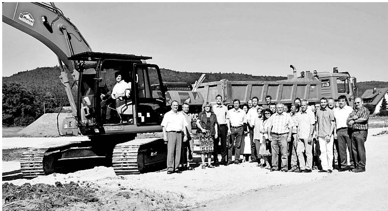
„Spatenstich“ mit Bagger: Bürgermeister Rögner (im Bagger) mit Investor Walter Maisel (links vorne), Gemeinderäten und Gästen im Gewerbepark Engelthal.
