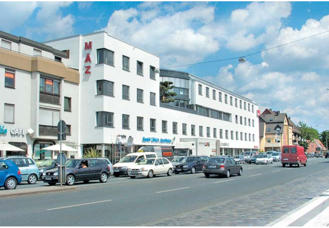
Ein würdiger Abschluss für die Nordseite des Mögelderer Plärrers: Das neue „Mögelderer Ärztezentrum“ schließt an der Ostendstraße 229 bis 231 die alte Baulücke und komplettiert den großen Platz. Fotos: Ochner
