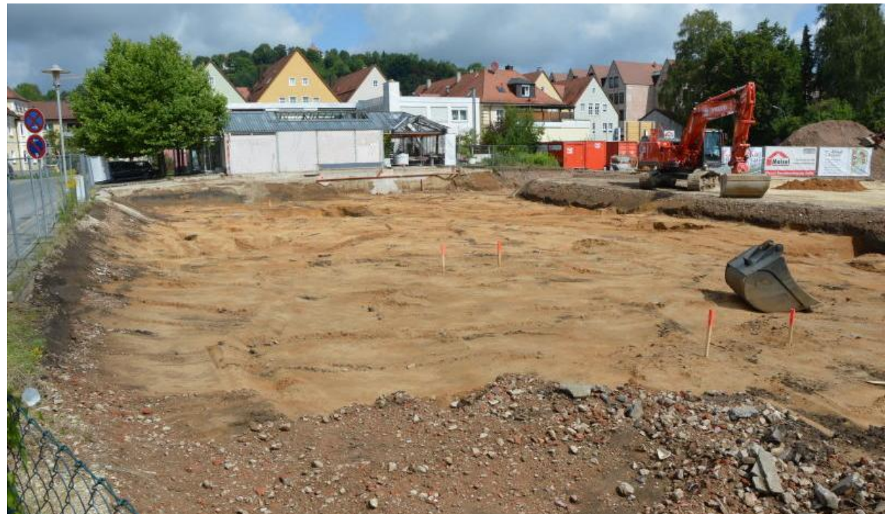
Das Fundament wird schon ausgehoben. Hier entstehen die ersten beiden Gebäude des „Altstadt-Carrés“.
