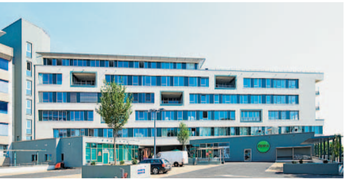
Lichtdurchflutete Loggien, Freibalkone und eine schicke Penthouse-Ebene mit herrlichem Blick übers Pegnitztal.
